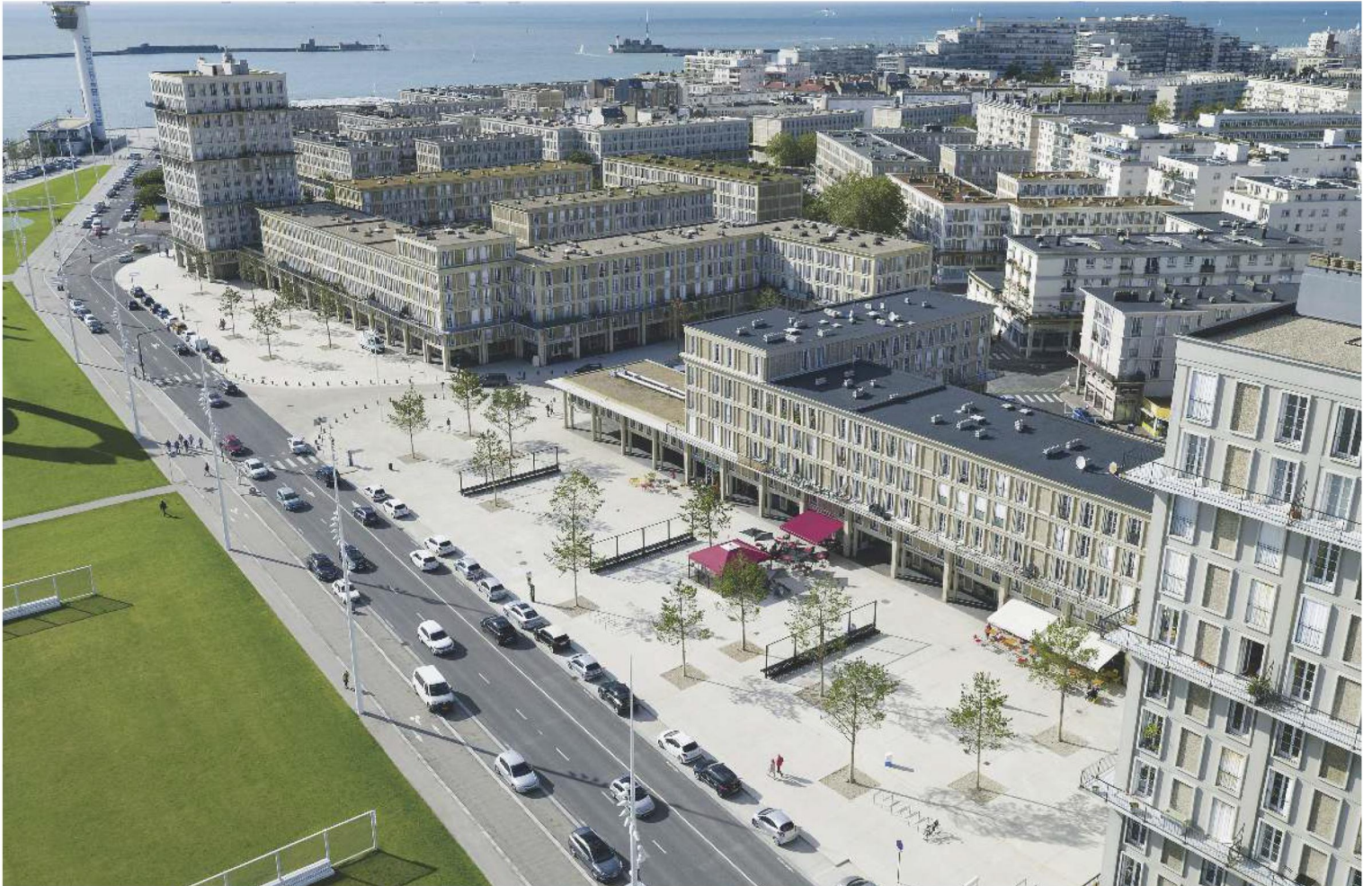
Côté ville, le sol en dalles de béton offre un socle aux façades en portiques de Perret et accueille les terrasses de café.
